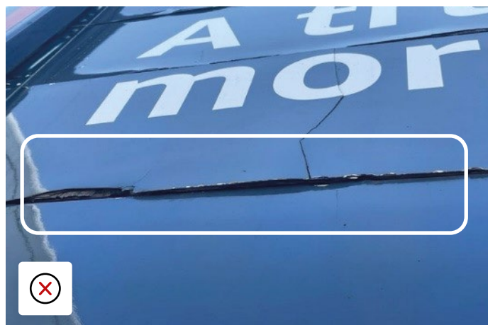
Pannello della porta dell'avvolgibile incrinato a causa di un urto
