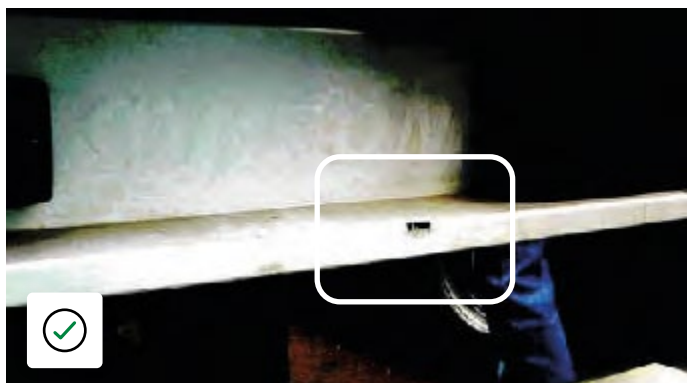
Danni da impatto che non alterano la struttura e possono essere puliti e verniciati con poca spesa
