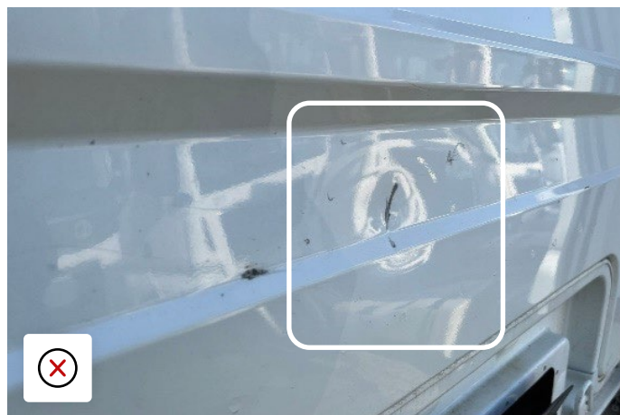
Danno da impatto sul retro della cabina che causa una crepa
