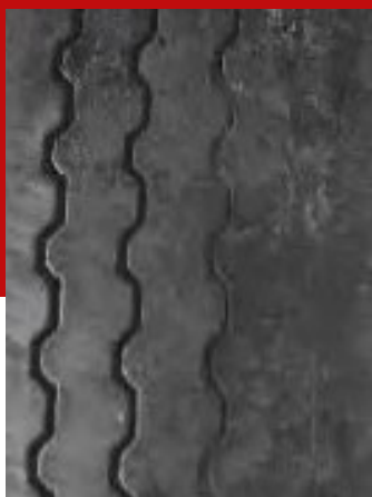
Usura irregolare dovuta a disallineamento o campanatura.
