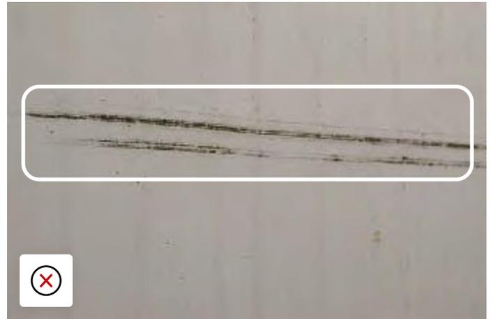
GRP Seitenpaneele wo die Gelcoatschicht gebrochen ist und Wasser einläuft oder sich Schimmel bildet.
