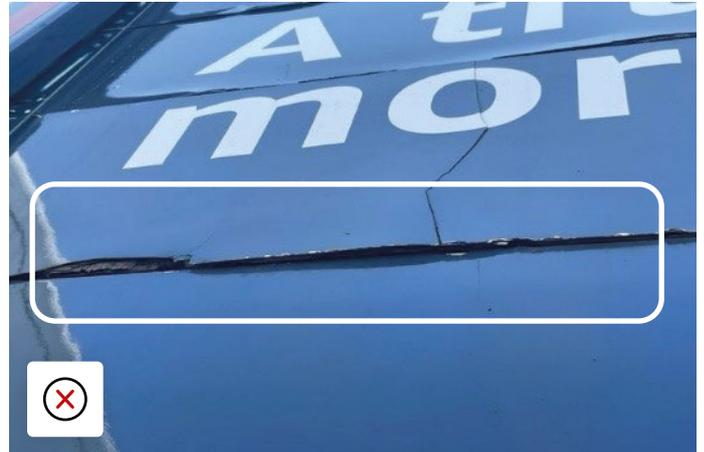
Türpaneel am Rolltor durch Aufprall gebrochen
