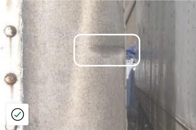
Beschädigte Eckpfosten, die eingedrückt sind, aber keine Löcher vorweisen.
