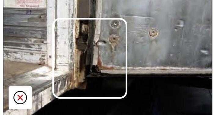
Alte Tür mit abgenutzter Innenseite, äussere Einwirkung an einer Ecke hat die Türpaneele und Schlösser so stark beschädigt, dass sie nicht ersetzt werden können.
