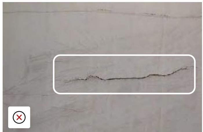
Kleine Risse lassen auf einen inneren Einschlag schliessen und können sich zu einem ernsten Schaden entwickeln. Sie sollten genauer untersucht werden.
