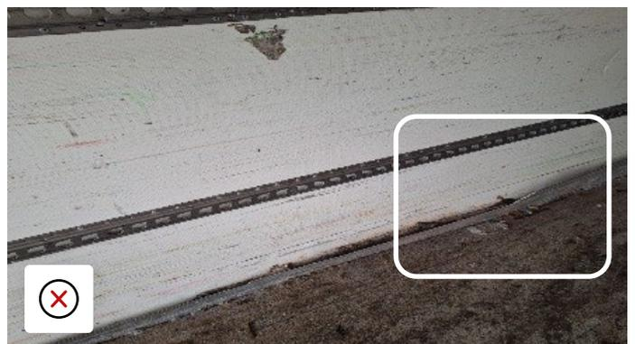
Anschlagsschutz beschädigt und vom Panel abgezogen.
