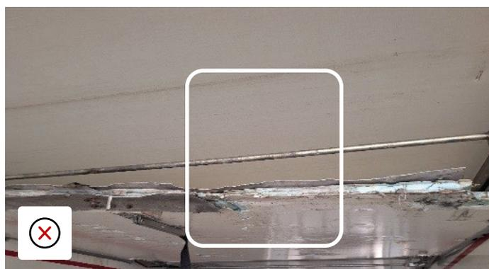
Beschädigte Trennwand mit freiliegender Isolierung
