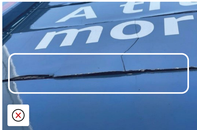
Prasklý panel dveří na roletě v důsledku nárazu
