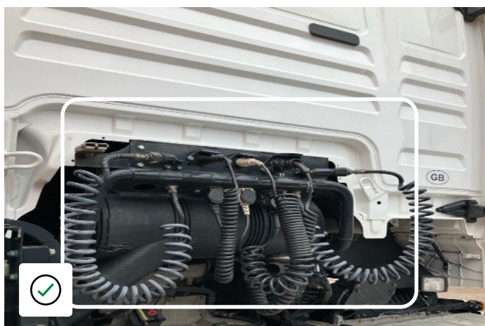
Propojovací prvky v dobrém stavu a správně uložené
