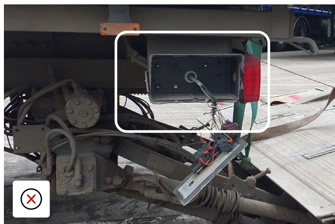
Rozbitý externí spínač - nutná výměna
