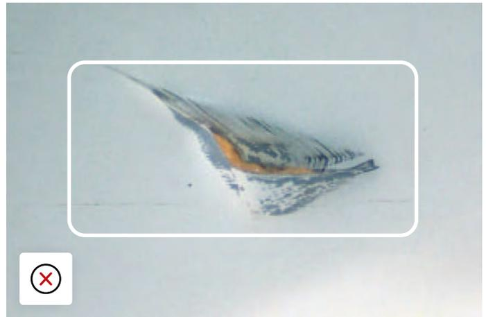
Panel de Ferroplast rallado y con superficie externa con incursiones que hacen que el aislante quede expuesto al agua y a la contaminación.
