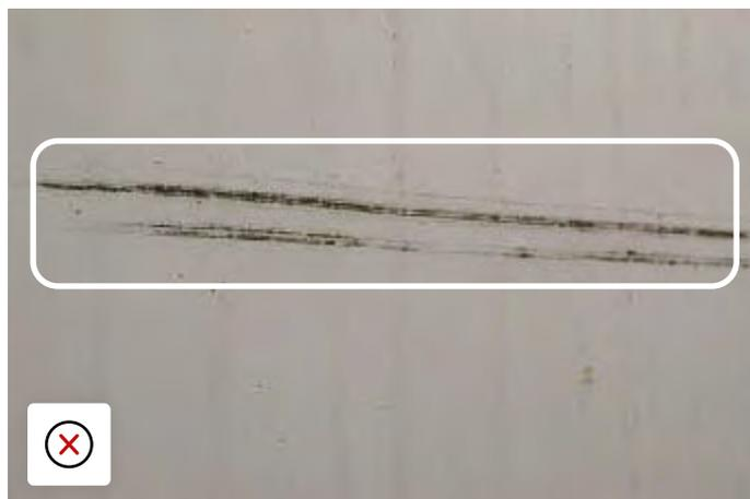
Arañazo en el panel lateral de fibra de vidrio con rotura de la capa de Gelcoat, penetración de agua resultante en infección por moho.
