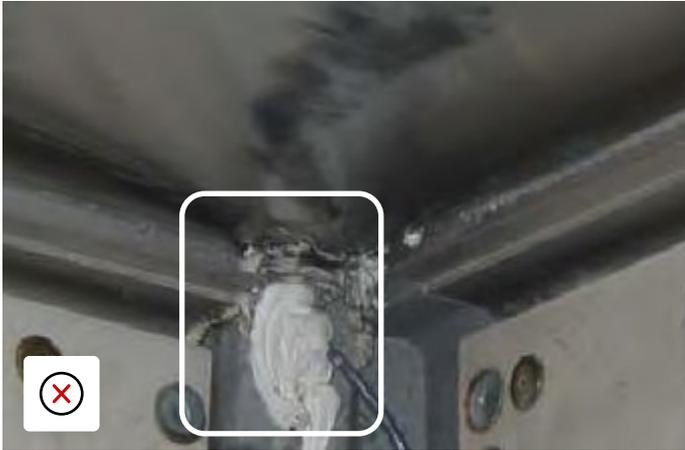
Daño en la lámina delantera del techo y en el alojamiento de la luz de galibo. También daños en el cabezal frontal, piezas de fundición de las esquinas, postes de las esquinas, guías superiores derechas y paneles.
