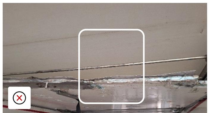
Separador dañado con aislamiento expuesto
