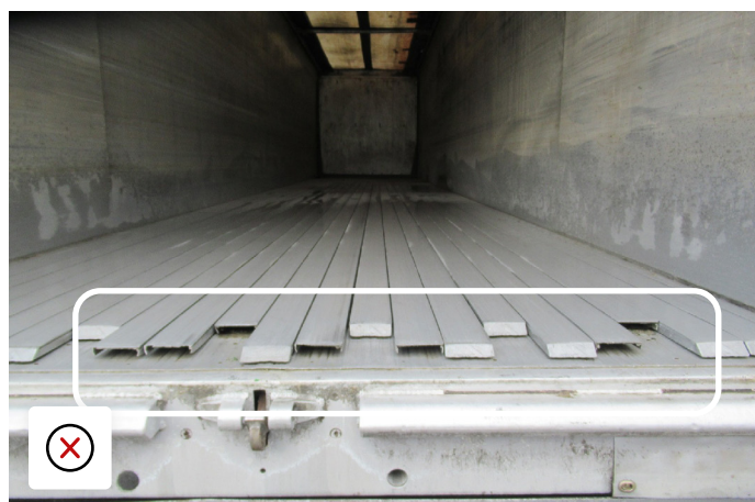
Brak krawędzi prętów - towary mogą spaść pod podłogę
