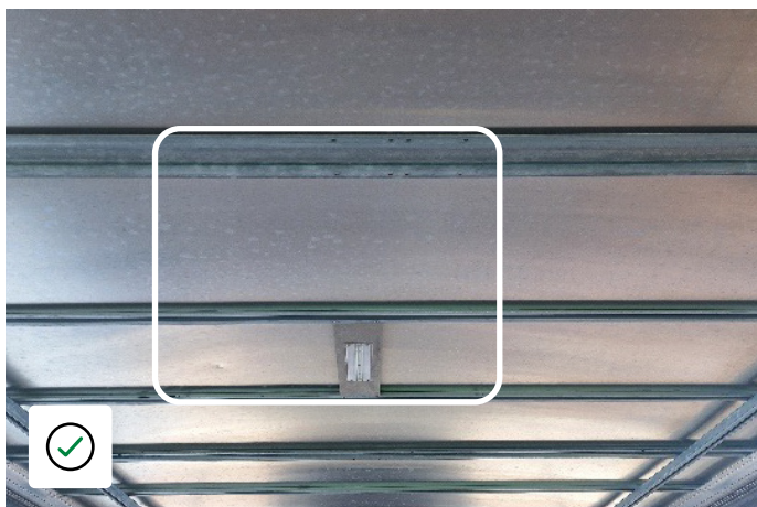
Poprzeczki dachu w dobrym stanie
