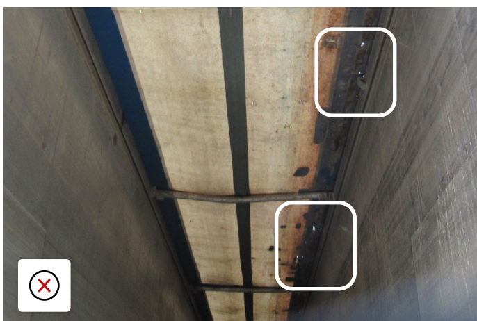
Otwory w ostonie - wymagają naprawy
