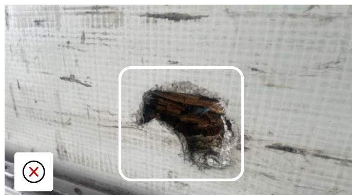
Przebity panel GRP i odstonięte wnętrze
