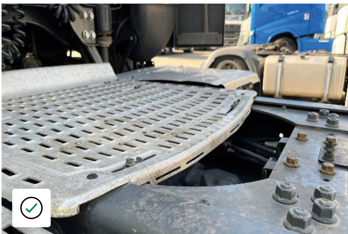
Deformare minoră prin uzură normală
