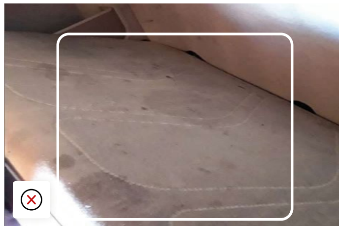
Saltea foarte murdară într-o stare inacceptabilă
